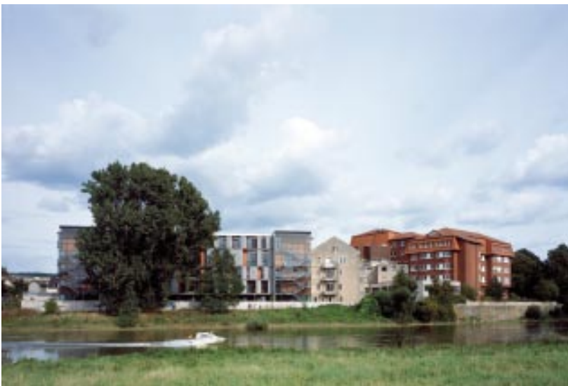
Ansicht des Ensembles von Westen mit Blick auf die Weser
