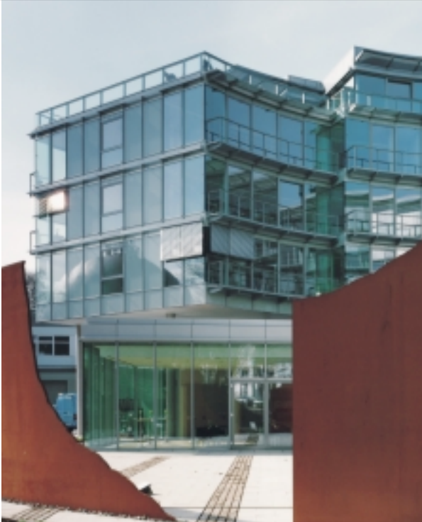
Stadtwerke Lüdenscheid Außenansicht, Fotos: © M. Hanisch, Düsseldorf
