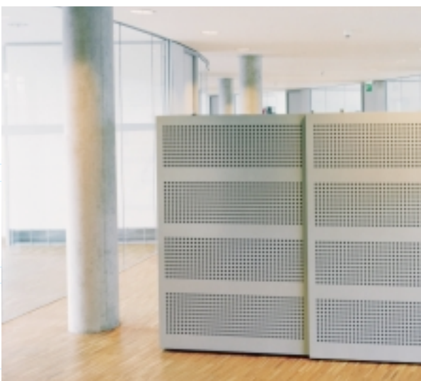
Büro mit ADO gTHERM Kühlung in den ORGA Wänden
