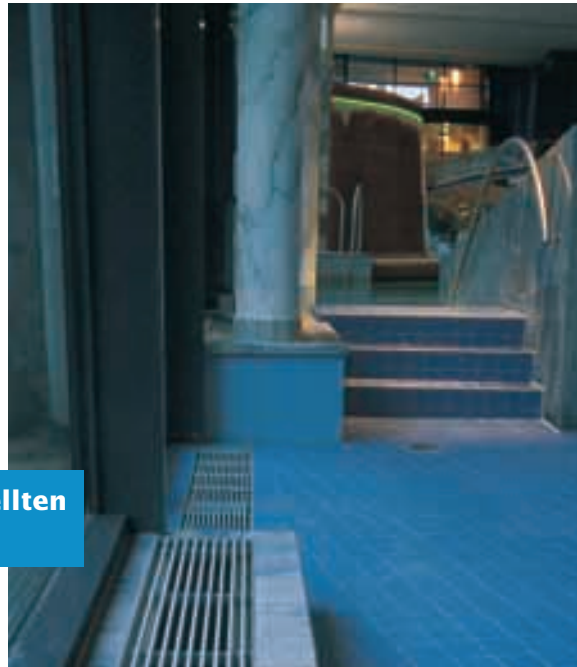
ADO Kammroste aus Aluminium zur Abdeckung von Konvektorschächten. Foto: Claudius Therme in Köln.
