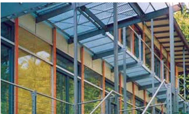
Ausführung: Fassadenrost als Fluchtbalkon und Fluchttreppe ▶ Design: Facade grate as an escape platform and stairs
