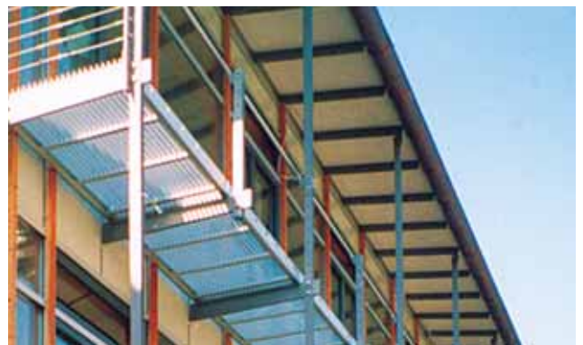
Ausführung: Fassadenrost als Fluchtbalkon und Fluchttreppe ▶ Design: Facade grate as an escape platform and stairs
