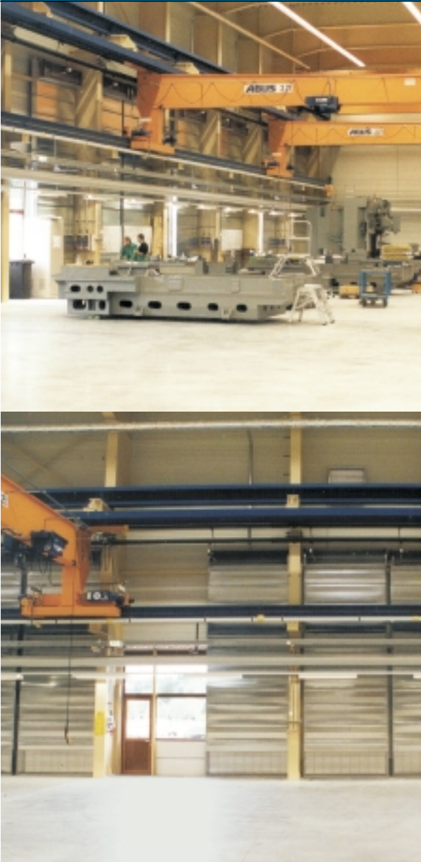
Die Anordnung des ADO gTHERM - Systems an der Hallenwand ermöglicht eine flexible Nutzung der Hallenfläche
