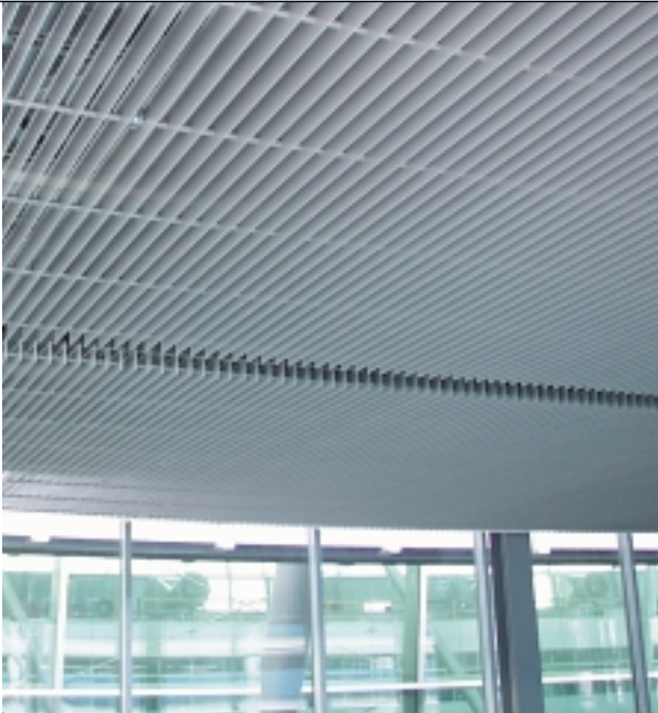
Detailaufnahme der Abhangdecke
