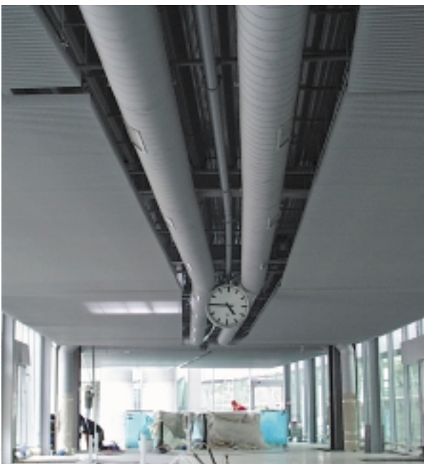
Innenansicht des PTS Bahnhofs während der Bauphase
