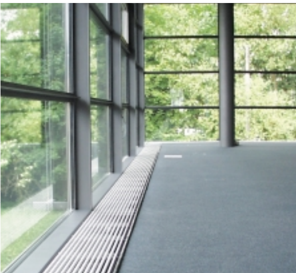
Bodenansicht im Bibliotheksgebäude
